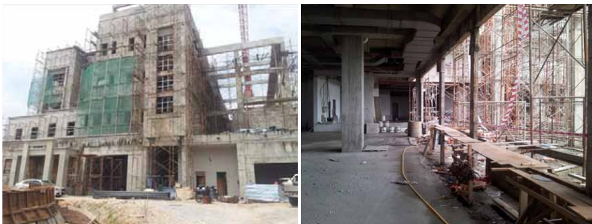
Bangunan Tambahan Mahkamah Baru Klang, Selangor
